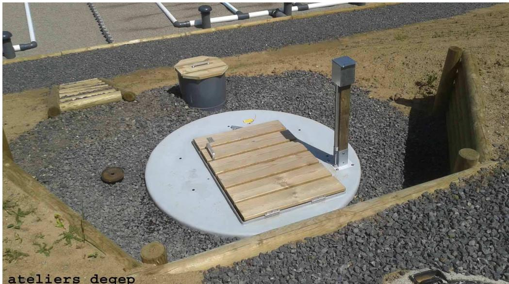
C'est le choix du dispositif d'alimentation qui permettra à un système d'épuration de type filtres plantés de fonctionner correctement. Le dimensionnement et la fiabilité du dispositif d'alimentation par bâchées, le choix des permutations des phases travail/repos des secteurs, la qualité de la répartition de l'effluent sur le massif filtrant, sont les points clés des systèmes d'infiltration/percolation.
