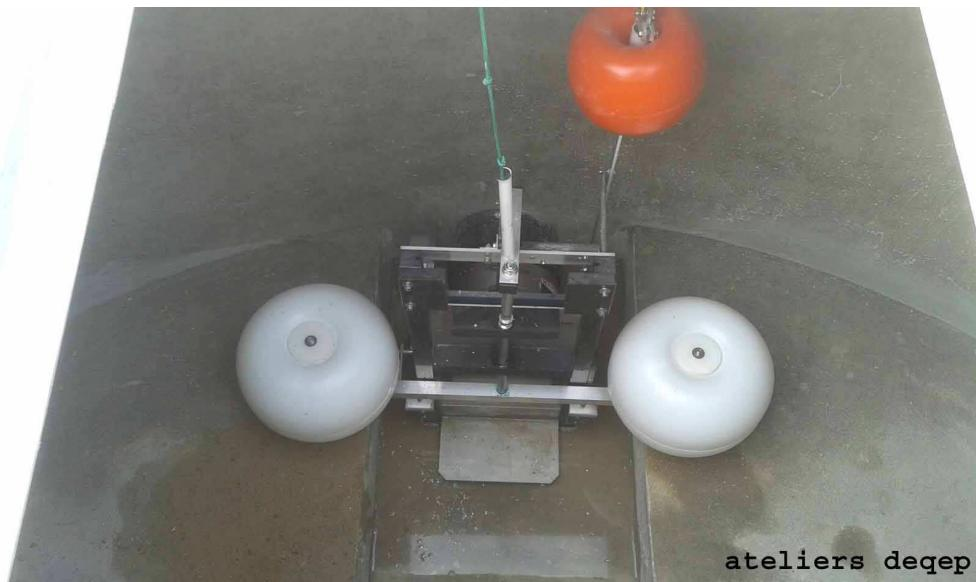
Ces ouvrages d'alimentation par bâchées, que l'on nomme aussi ouvrages de chasse, sont en règle générale destinés à être enterrés.
