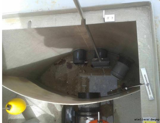
Soit déportée de la cuve, du type « tabouret » : Chambre d'Aiguillage Déportée (CAD). A partir de 70 EqH. (> 800L de bâchée pour 3 cm de lame d'eau sur le filtre)
