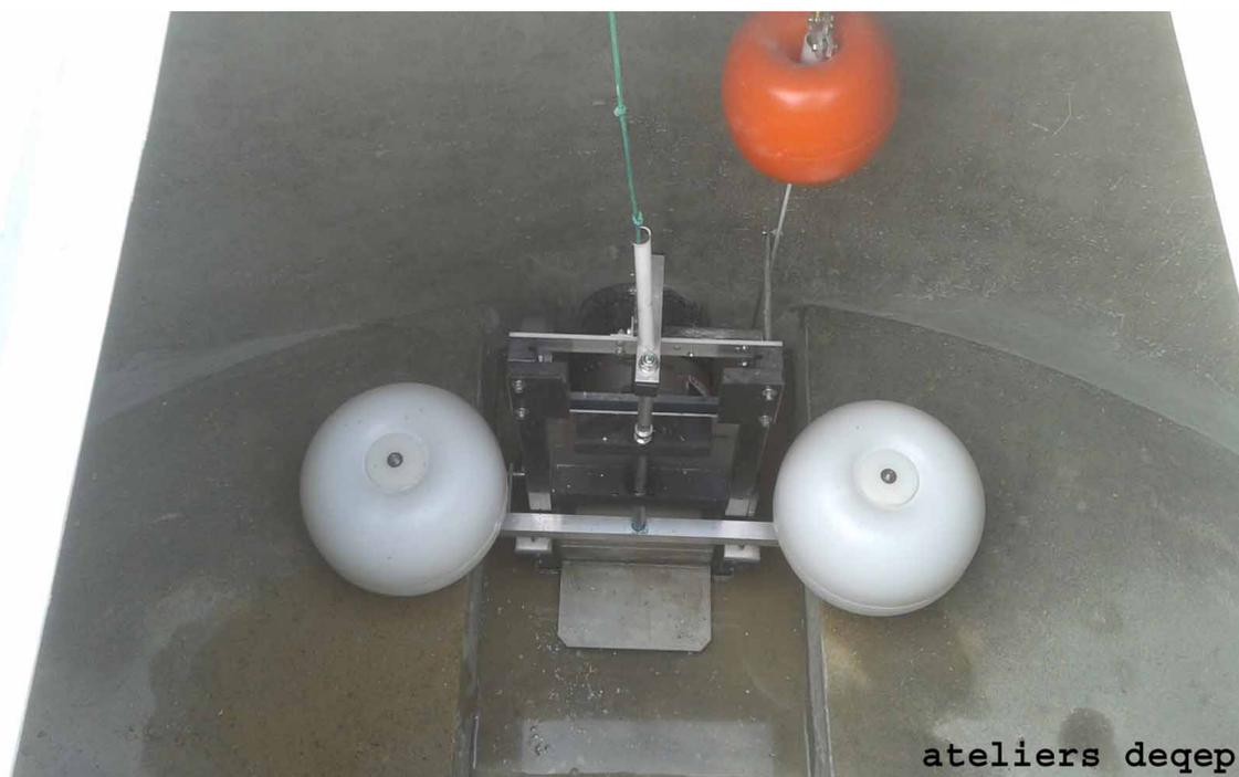
La vanne de chasse automatique des **ateliers deqep** est raccordée au piquage de sortie en fond de cuve. C'est une vanne de type murale à guillotine.
