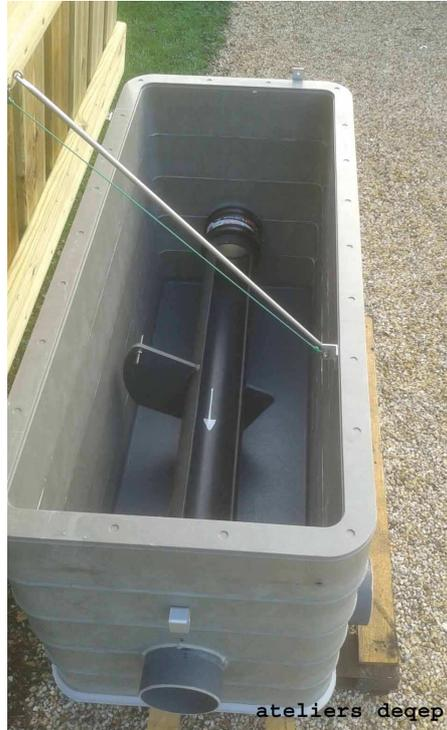
Les déversoirs d'orages sont des ouvrages destinés à limiter le débit d'eau entrant dans la step par temps de pluie.
